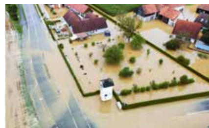
Verheerende Hochwasserschäden in der Gemeinde Mureck, Steiermark
